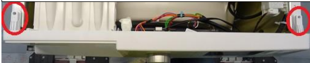
Image 1.8 Démontage/assemblage du panneau
