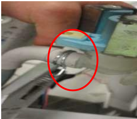
Image 1.46 Installation / Démontage de la valve
