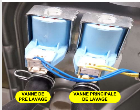
SCHÉMA E4 -1 : Vannes d'admission d'eau
